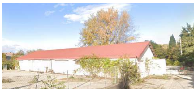
2- vue sur l'entrepôt existant
