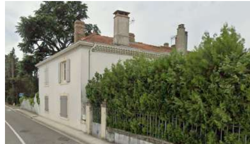
Vue sur l'habitation existante située au Nord du site offrant un potentiel de division parcellaire
