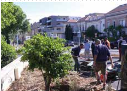
Aménagement paysager des Espaces verts, préparation du terrassement, mise en place des végétaux, installation de l'arrosage.
