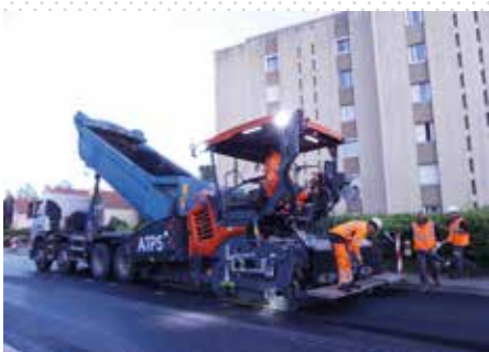
Réalisation de l'enrobé définitif avec la pose de la couche «bitume finition»
