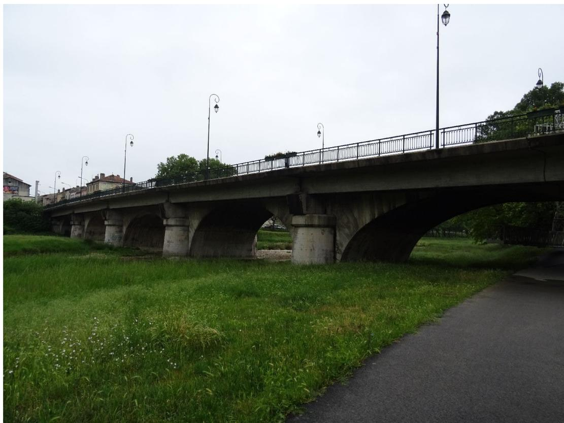
Le pont mesure 142 ml et d'une largeur de 15.80 ml avec une chaussée de 12.20 et de deux trottoirs de 1.56 ml munis de garde-corps et d'un éclairage. Il est constitué de 5 voûtes maçonnées et 4 piles
