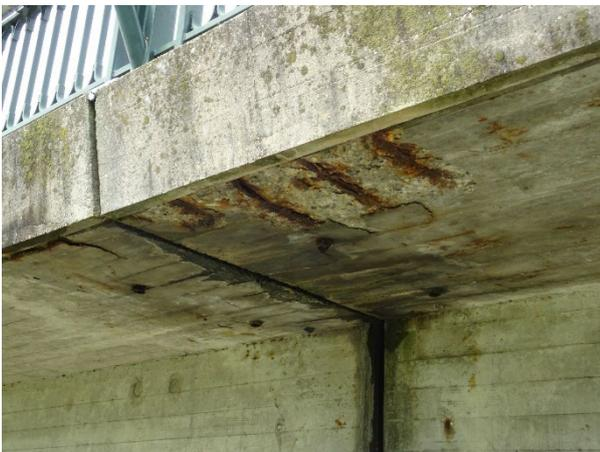
Encorbellement : acier apparents corrodés
