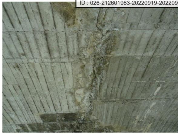
Voute : Fissure sur reprise de bétonnage
