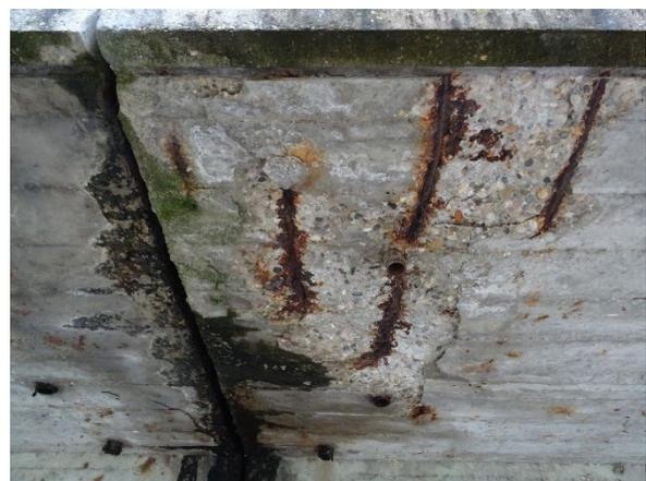
Fissure sur reprise de bétonnage en clé
