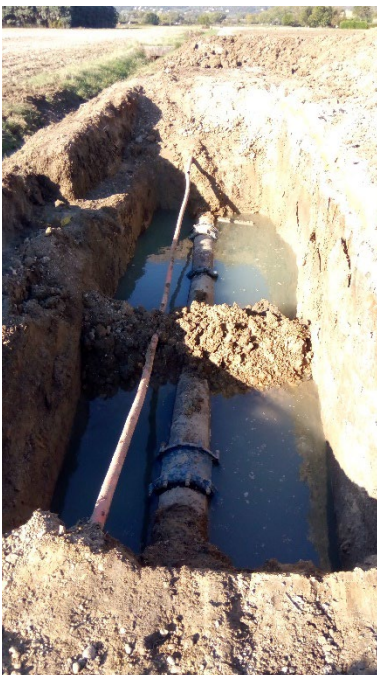
Fuites sur la canalisation source « la Dame » Fonte DN500mm (octobre 2016 et juillet 2017)
