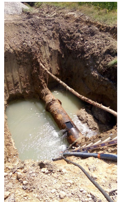
Fuites sur la canalisation source « la Dame » Fonte DN500mm (octobre 2016 et juillet 2017)
