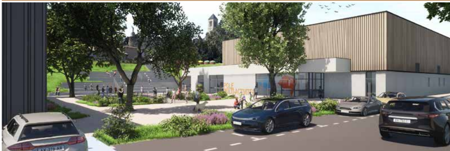
Salle Multi-Activités et Services Techniques à Montboucher-sur-Jabron (26)
