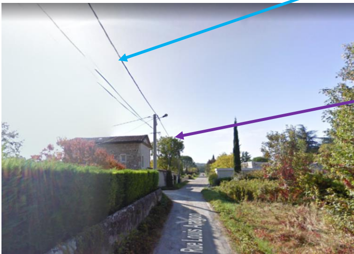
Ligne électrique aérienne maintenue
