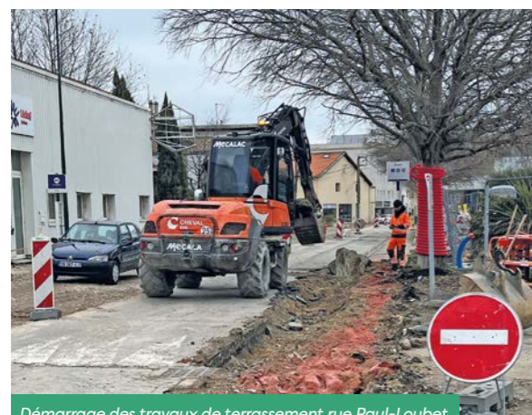
Démarrage des travaux de terrassement rue Paul-Loubet.
