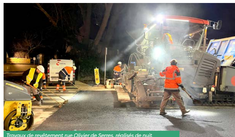
Travaux de revêtement rue Olivier de Serres, réalisés de nuit pour limiter les nuisances sonores et l'impact sur la circulation.
